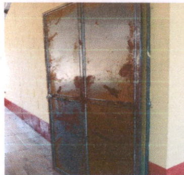
Foto 2: Sustitución de puertas de madera por metal.
