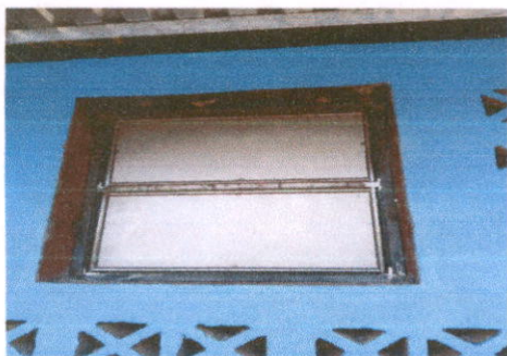
Foto 3: Sustitución de ventanas de madera por metal
