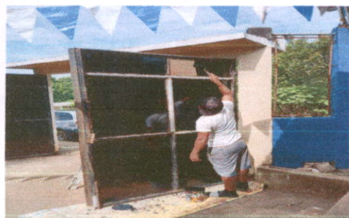
Foto 5: Mantenimiento a portones de metal.
