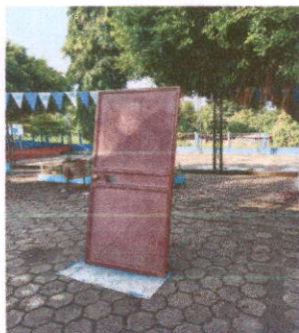
Foto1: Sustitución de chapas en 13 puertas.
